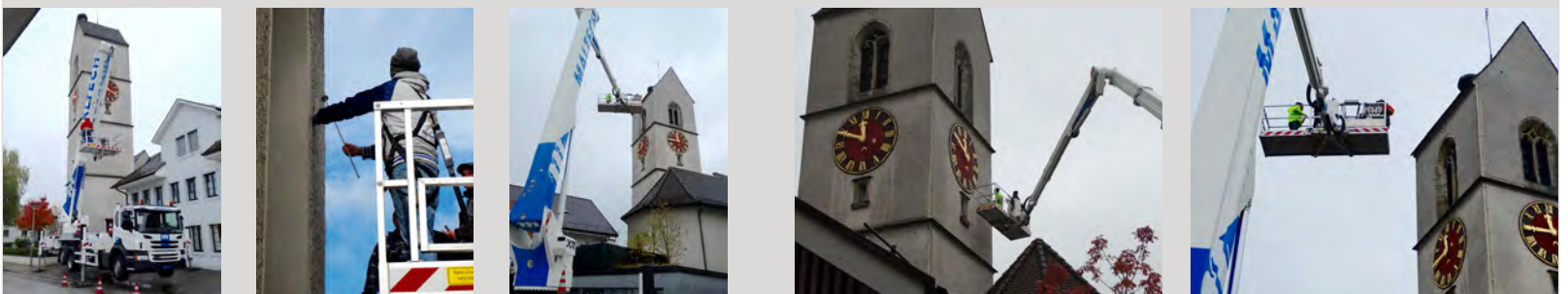
Wie ‚gesund‘ ist unsere Kirche? Spektakulärer Fassadenuntersuch mit Kran und Hebebühne
